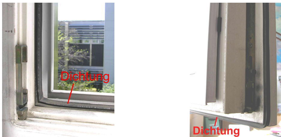
Abbildung 4: Dichtungen an Fensterrahmen und Fensterflügel
